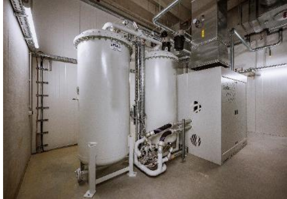
Zuurstofverlaging installatie
