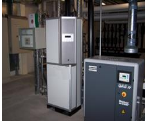
Zuurstofverlaging installatie
